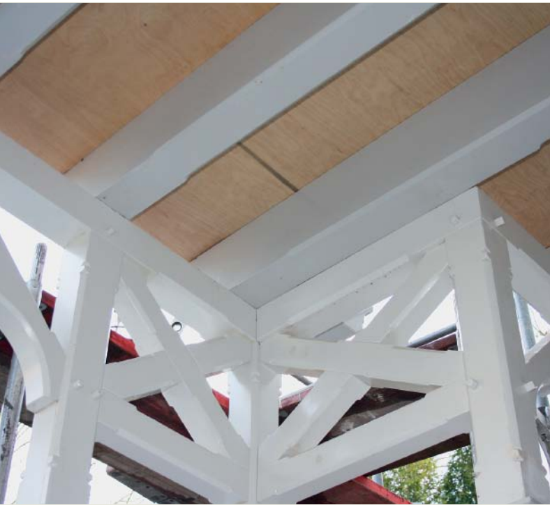
Die Holzkonstruktion (links) wurde nach historischem Vorbild konstruiert. Auf dem farblich angepassten, mit einem 2-prozentigen Gefälle angebrachten KVH-Trägern liegt eine Mehrschicht-Holzplatte. Ein Stahlträger (rechts) und zusätzliche Fixpunkte halten die Konstruktion am Mauerwerk.
