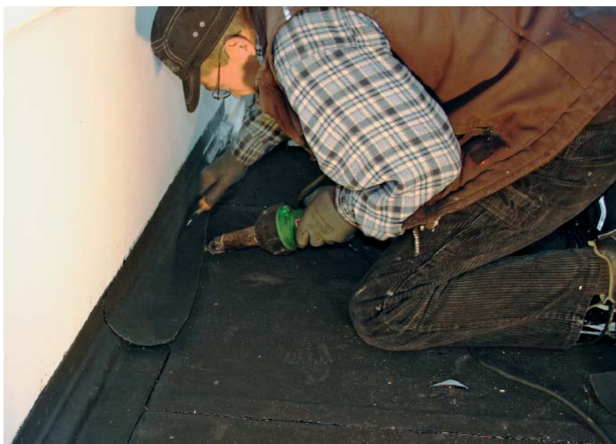
Der Nahtverschluss erfolgte mittels Heißluft.
